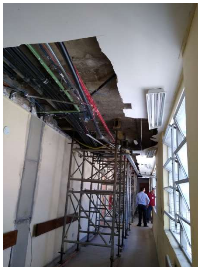
Figura 22: Vista de corredor do bloco G3 interditado e linhas de escoramento das vigas que se apoiam no pilar P62 na face inferior da laje do 2º pavimento do bloco G3.
