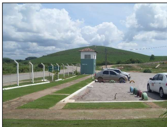
Figura 10 – Guarita de segurança. O acesso ao aterro é controlado, com segurança 24h.
