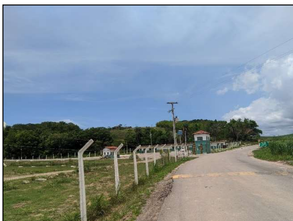
Figura 9 – Vista geral da entrada do aterro. Todo o perímetro do terreno é cercado.
