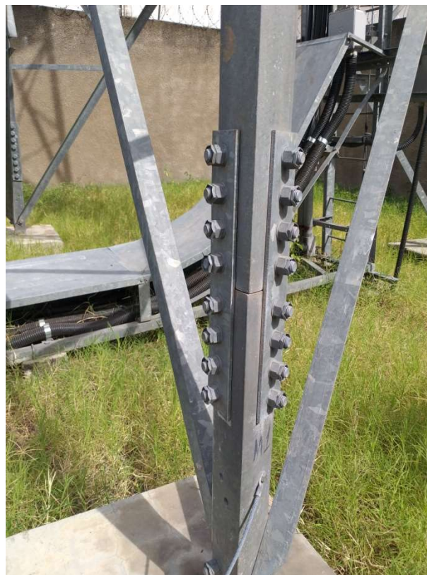
Figura 12: Torre da Estação de Ouro Preto.
