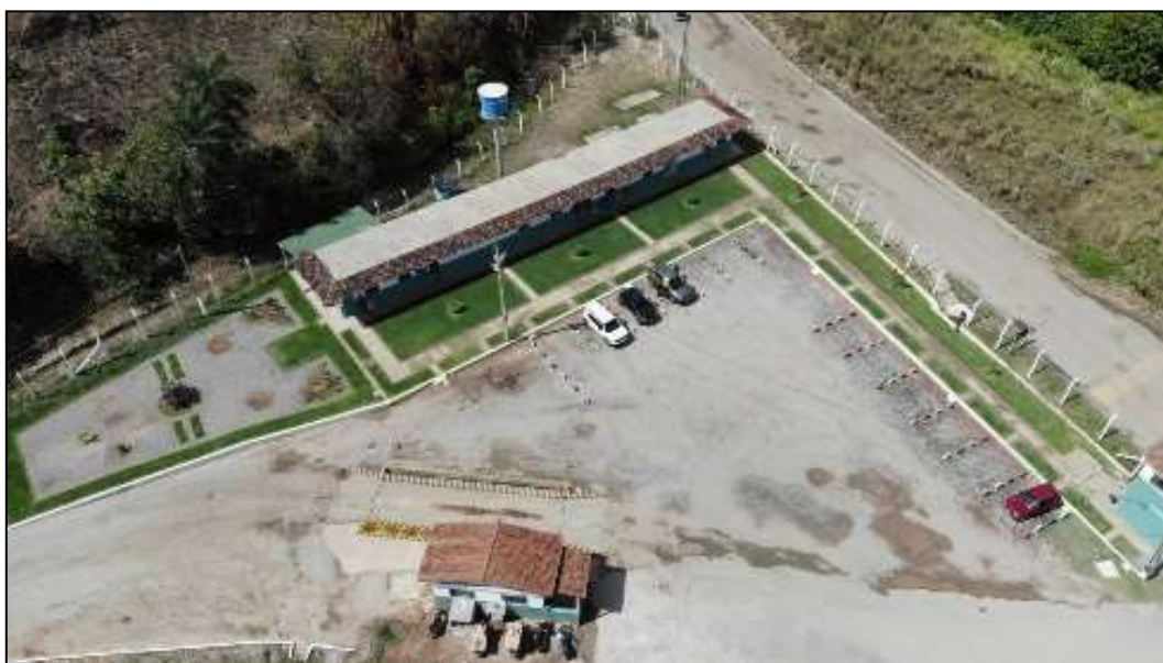
Figura 8 – Vista aérea da guarita, balança e administração. Fonte: CAEL Engenharia.
